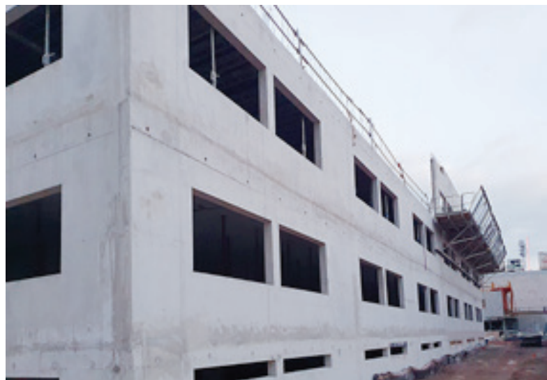
Les futurs bâtiments sortent enfin de terre !
