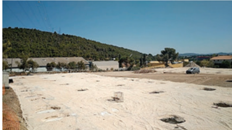
Commencement des travaux par le terrassement du terrain, nécessaire pour la construction des nouveaux bâtiments.
