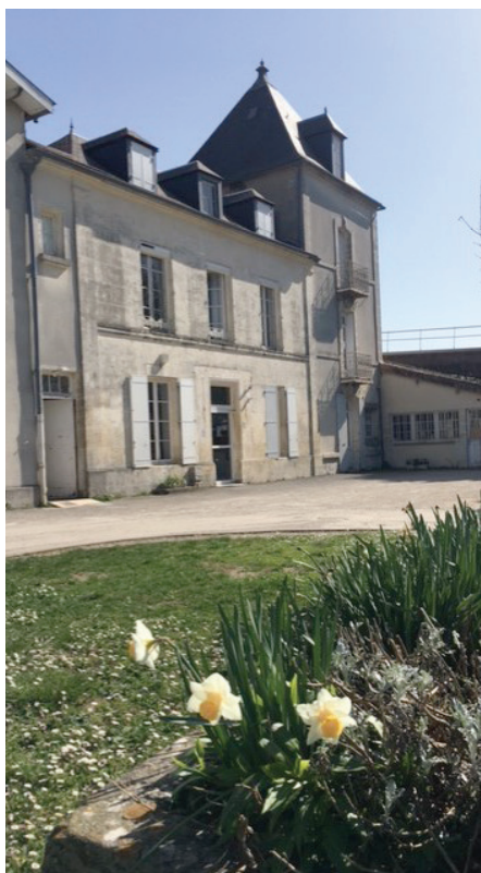
Le bâtiment administratif
