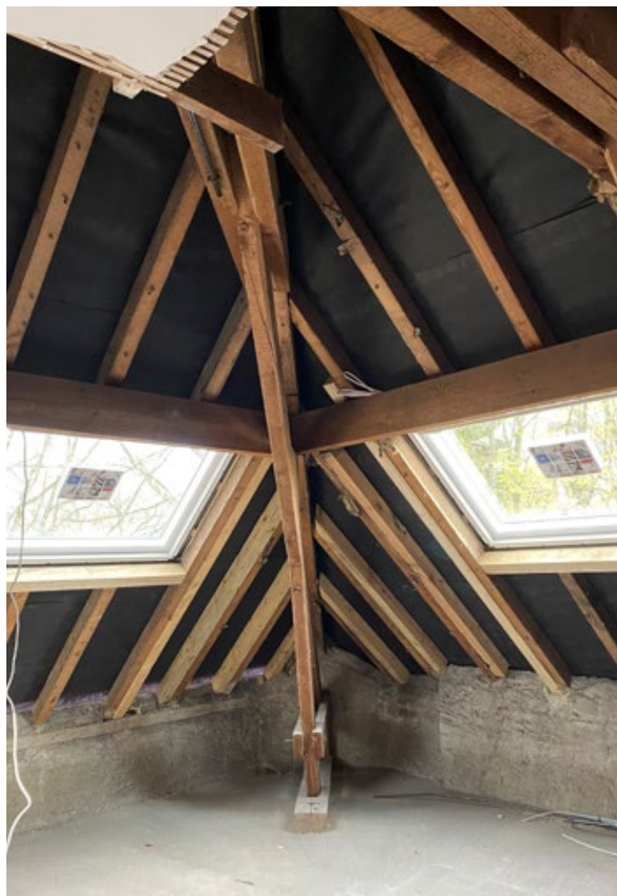
Remplacement de la toiture avec pose de Velux
