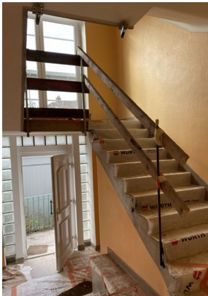
L'ancien garde-corps a été enlevé, en attendant le nouveau et il y a un provisoire pour sécuriser le chantier.
