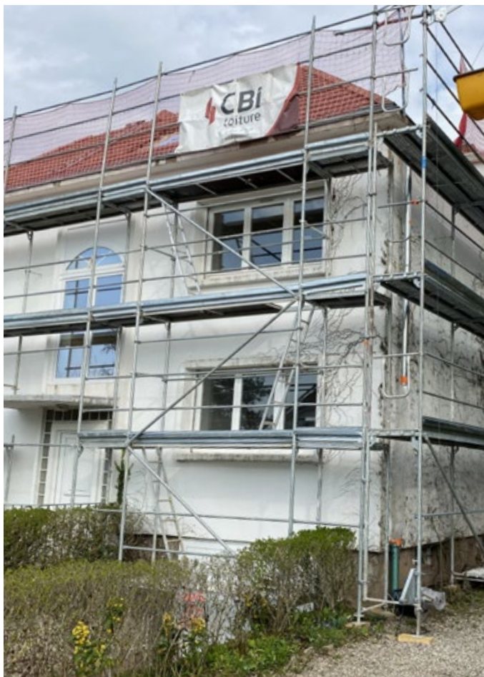
L'échafaudage sert dans un premier temps à sécuriser les travaux de remplacement de la toiture, puis servira au ravalement par isolation de la façade.
